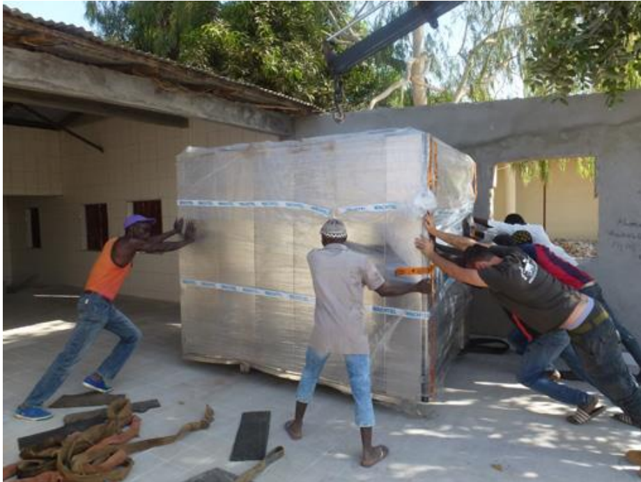
Wir haben den 9. Februar und das Herzstück der neuen Bäckerei wird in einem gemeinsamen Kraftakt eingesetzt.
